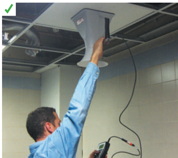
Auto-contrôle pour vérifier les débits d'air avant la réception. ©AQC-2016
