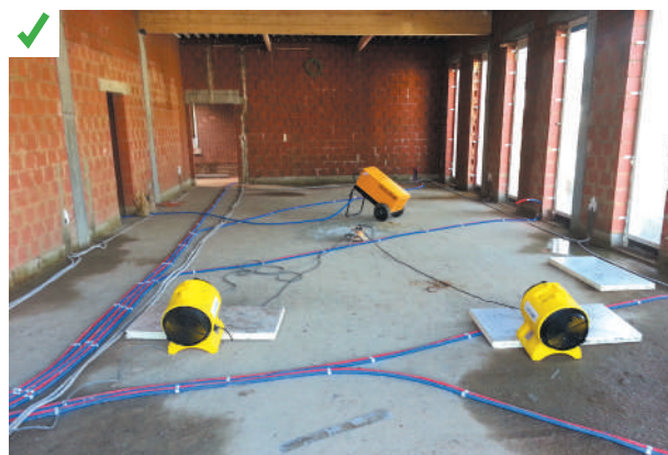
Exemple de dispositif d'assèchement de chantier. ©aerostar
