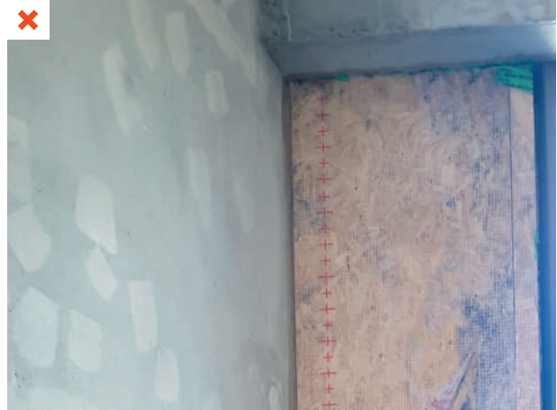
Mise en œuvre d'un OSB qui a moisie durant son stockage, du fait de son exposition à la pluie. ©AQC-2016
