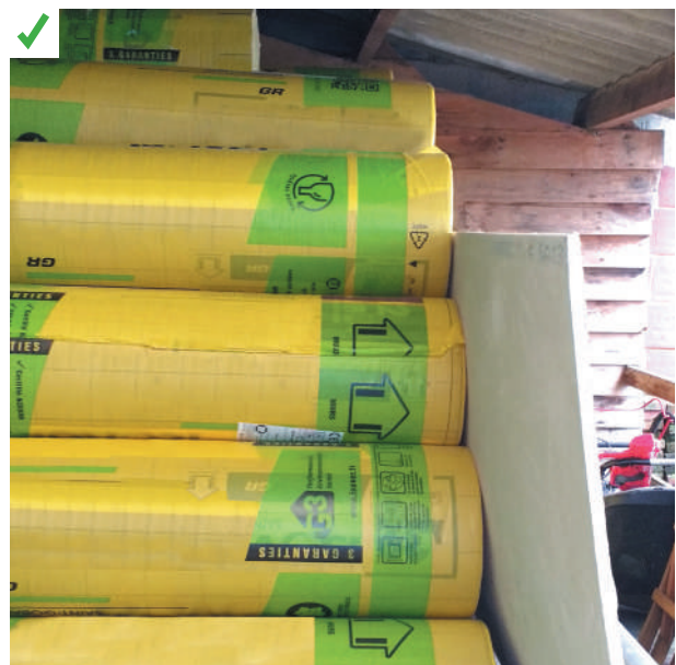
Stockage de matériaux à l'abri de la pluie. ©AQC-2016
