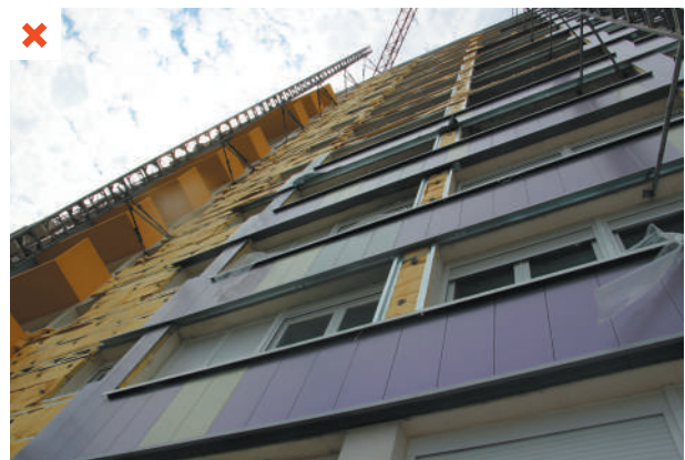
Pose de l'isolant sans protection - pose du bardage tardive. ©AQC-2016
