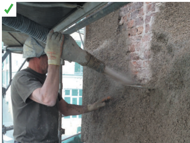
La projection d'un béton de chanvre permet de maintenir le potentiel d'assèchement du mur côté extérieur. ©atelier-d
