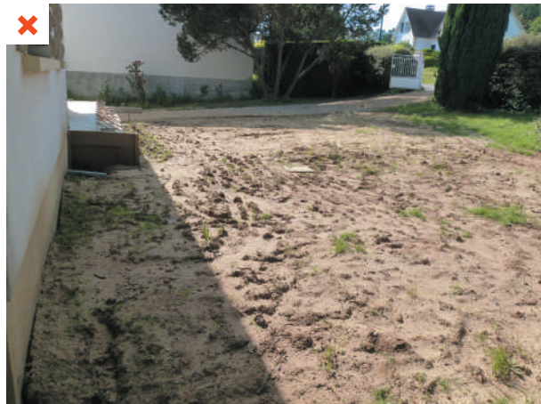
Non-traitement de la pente et destruction de la végétation lors de la réalisation de travaux engendrant d'importantes infiltrations en pied de mur. ©AQC-2016
