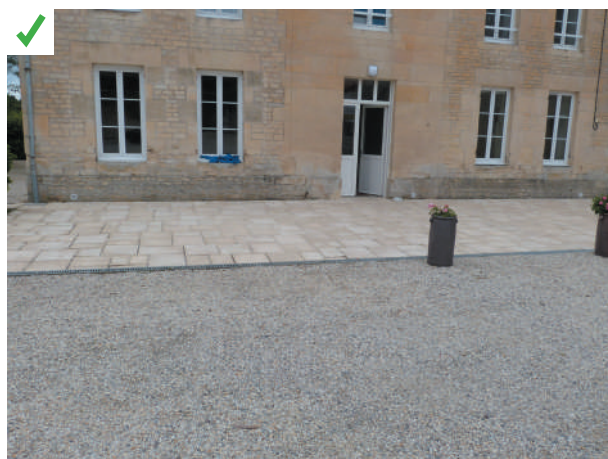
Terrasse équipée d'un caniveau, avec une pente éloignant l'eau du bâtiment. ©AQC-2016
