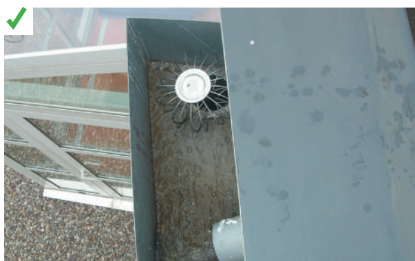
Nettoyage régulier des boîtes à eaux. ©AQC-2016
